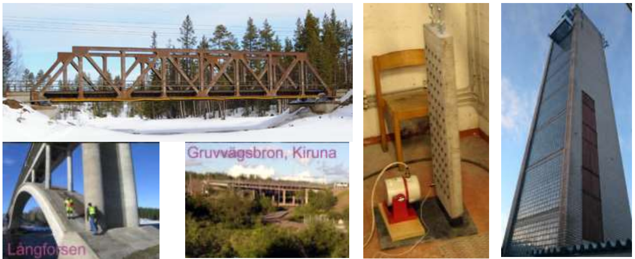
Figur 2.1. Studerade konstruktioner. Överst fackverksbro över Åby älv, Nedtill från vänster: bågbro över Kalix älv, spännbetongbro vid LKABs gruva i Kiruna samt till vänster en hängande betongplatta och ett exempel på ett niovåningars betongtorn.
