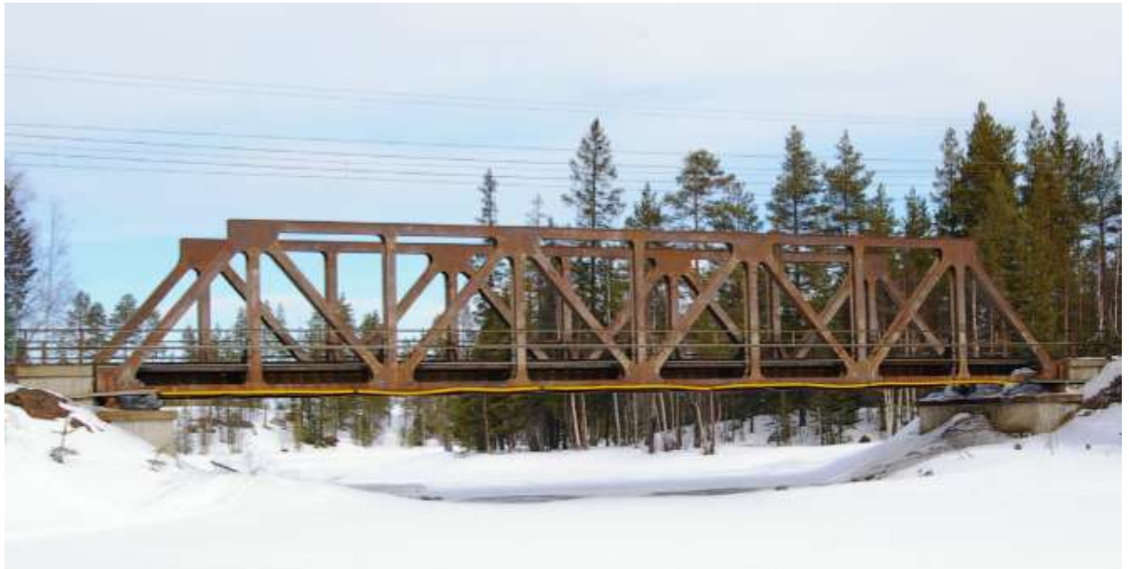
Figur 4.7. Järnvägsbron över Åby älv från 1955. (Foto Thomas Blanksvärd)
