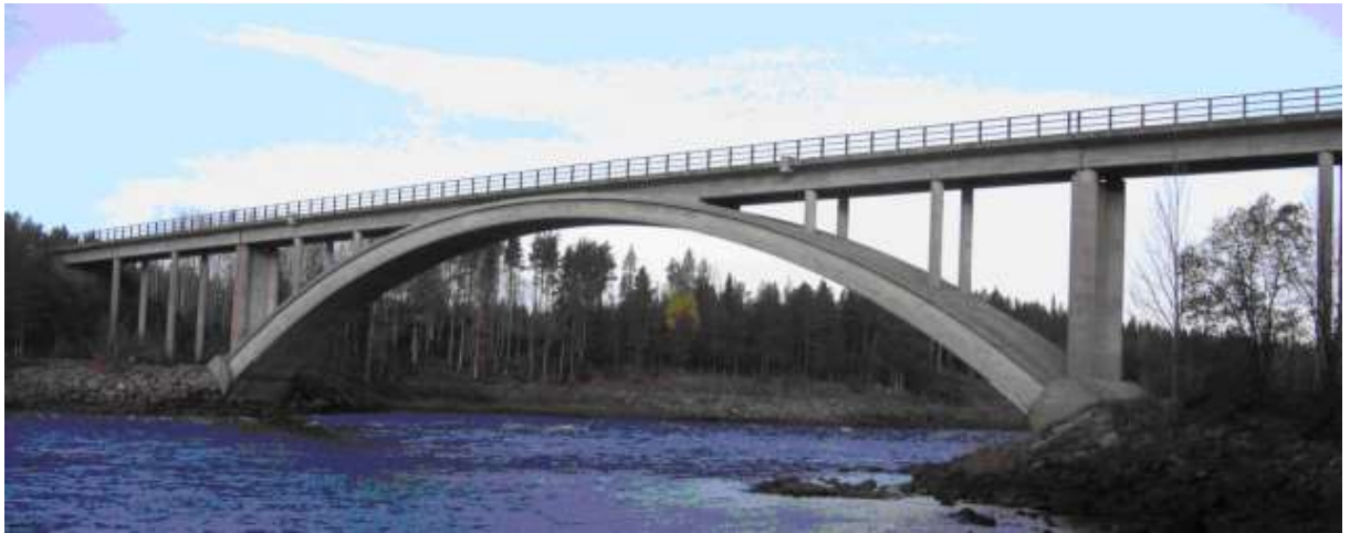
Figur 4.4 Järnvägsbron vid Långforsen över Kalix älv byggd 1960. Bågen har 87 m fri spannvidd.
